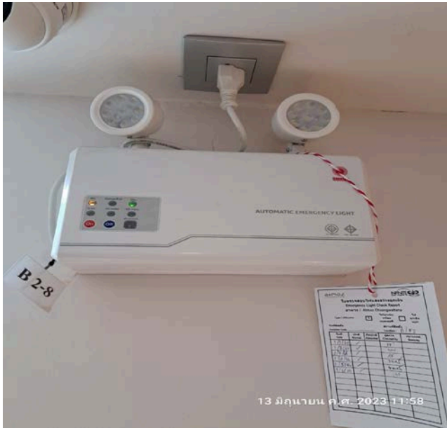
รูปที่ 2.6.3-3 ระบบไฟฟ้าส่องสว่างฉุกเฉิน
