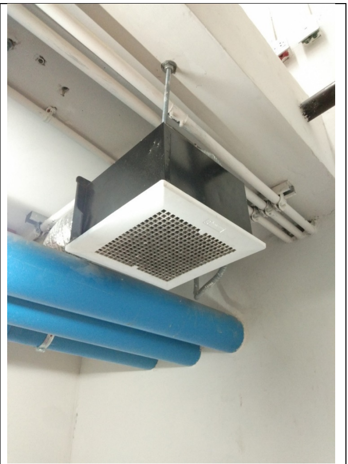
รูปที่ 2.7.5-2 ระบบระบายอากาศโดยวิธีกล
