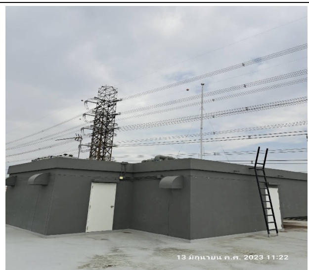
รูปที่ 2.4.1-2 ถังเก็บน้ำชั้นดาดฟ้า
