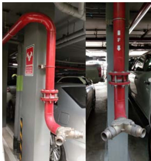
รูปที่ 2.7-2 หัวรับน้ำดับเพลิงภายในอาคาร
