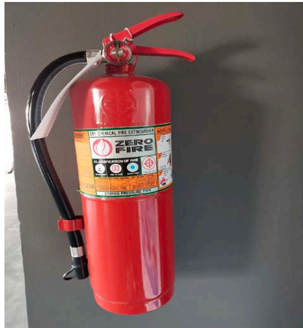
รูปที่ 2.6-4 ถังดับเพลิงมือถือขนาด 10 ปอนด์
