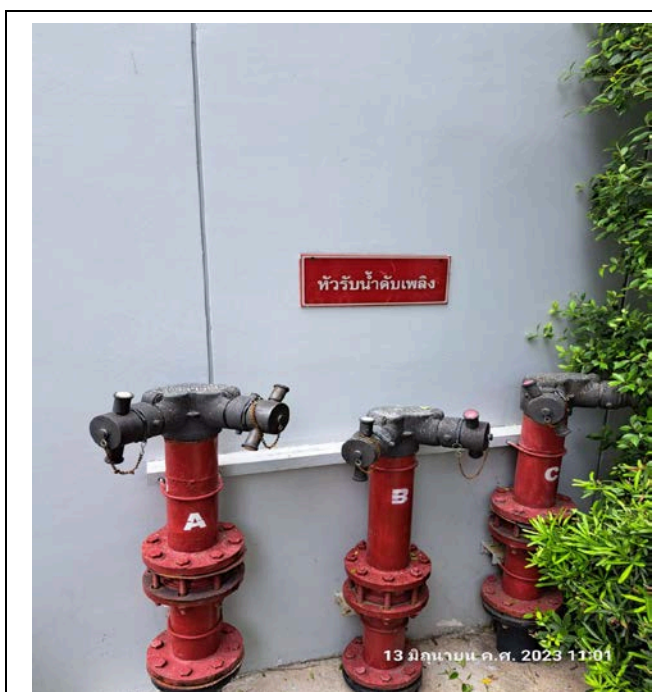
รูปที่ 2.6-1 หัวรับน้ำดับเพลิงภายนอกอาคาร
